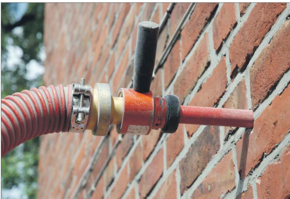
Die alte Fassade bleibt vollständig erhalten. Um das Isoliermaterial einzubringen, müssen nur Löcher in die Fugen gebohrt und hinterher wieder geschlossen werden. Fotos dt
